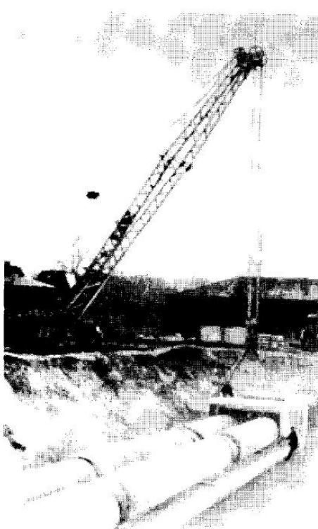
Рис. 3.8. Монтаж теплопроводов в полу-проходных каналах
